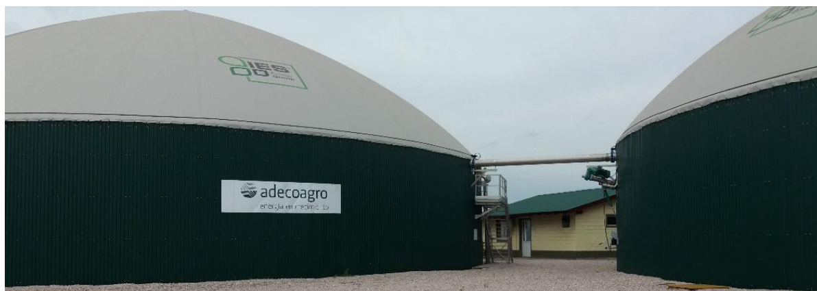
2. Planta de biodigestión anaeróbica de la empresa Adecoagro (1.4 MW de potencia instalada) Christophersen (Santa Fe).
