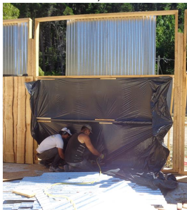
Foto 1: láminas de polietileno dentro del espacio del entramado
