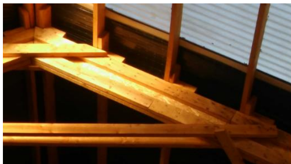
Foto 2: vigas doble "T"
