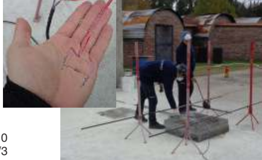
Figura 12: Izquierda: cable detector del sistema ABC 90. Derecha: operarios montando el bastidor con el cable detector sobre la bandeja de evaluación con combustible clase “B”.
