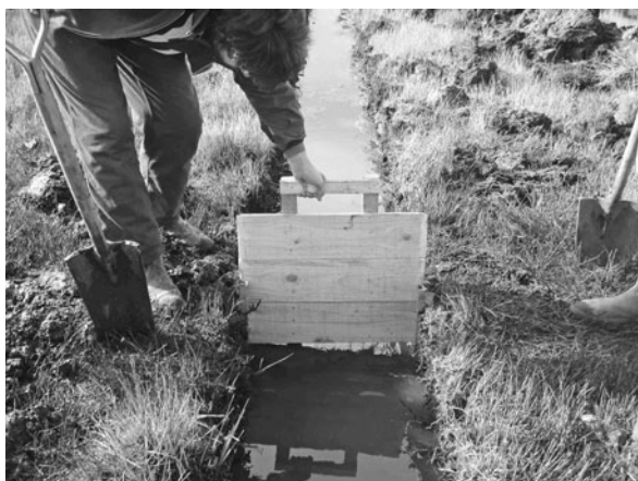
Instalación de compuertas
