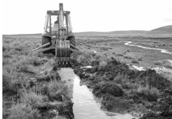
Construcción de canales
