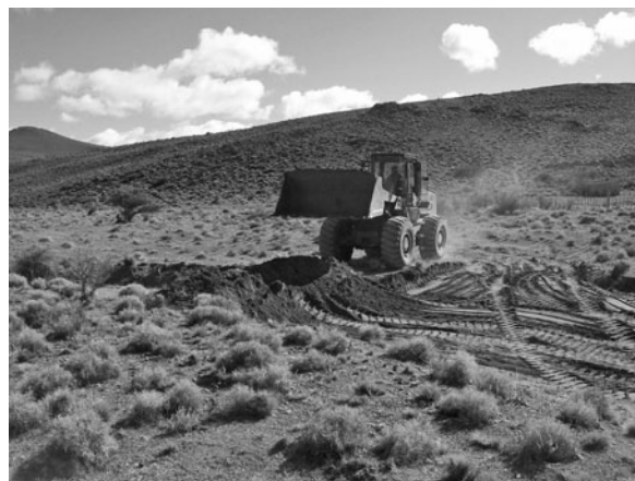
Construcción de diques
